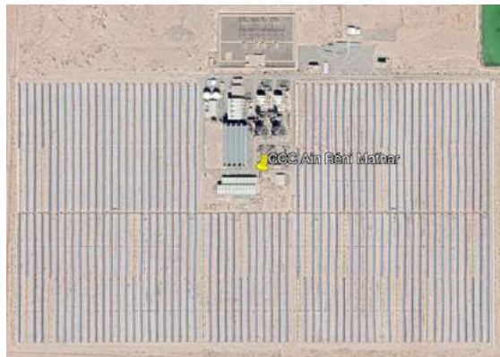
Abbildung 8, Solar-Hybridkraftwerk Ain Béni Mathar (Google Earth)
